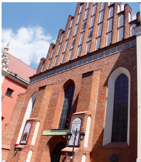
Elewacja katedry tylko przypomina gotyką – pod ceglami jest betonowa konstrukcja
