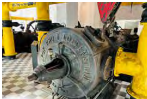
Fragment zachowanej instalacji
