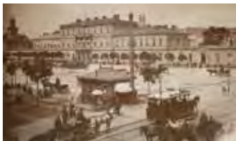
Dworzec Wiedeński w Warszawie, ok. 1890 r.
